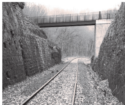
Km 10,6 : pont sur la voie ferrée de Sarreguemines à Bitche
