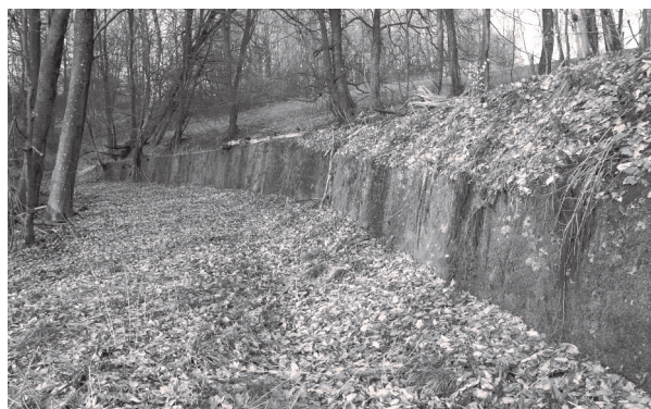
Km 21,6 : mur de soutènement. La voie ferrée arrive de Saint-Louis sur la plateforme en partie basse du mur. Après rebroussement, la voie repart vers le Simserhof en partie haute du mur.
