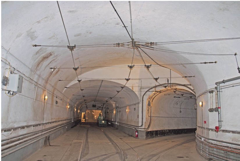
Galerie principale du Simserhof à proximité de l'entrée des munitions, trois voies électrifiées en 600Volts continus. À gauche une voie directe, à droite un aiguillage avec deux voies en bifurcation (état actuel).
