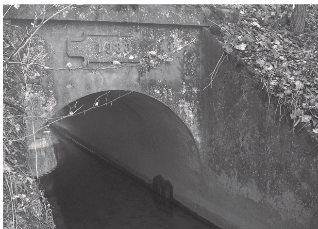
Km 0,5 : pont datant de 1933, sur le ruisseau de Saint-Louis, le Münzbach
