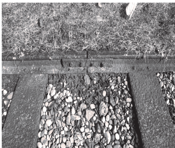
Km 26,700 : une portion de voie de 60 devant l'entrée des munitions du Simserhof avec un joint de rails éclissé et deux traverses métalliques rivetées au rail à travers le patin.
