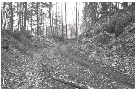
Km 11,7 : partie de voie en tranchée et en courbe.
