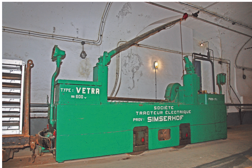
Locotracteur électrique 600V, courant continu, Vetra (Société des Véhicules et Tracteurs Electriques) au Simserhof, avec son pantographe levé (état actuel).
