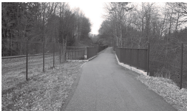
Km 10,2 : pont sur la rue du Moulin à Lemberg, piste cyclable aujourd'hui
