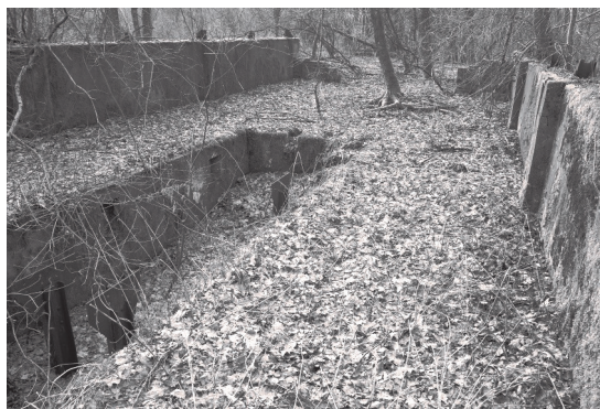
Km 0,1 : l'atelier d'entretien du matériel roulant (locotracteurs et wagons) avec sa fosse de visite
